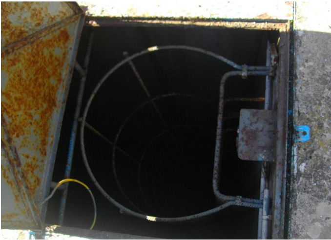
Scala interna di accesso al cunicolo d'ispezione
