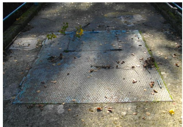
Botole di accesso al cunicolo d'ispezione
